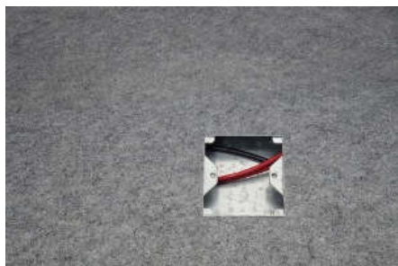
Kabel im den Kabelkanal eingezogen
