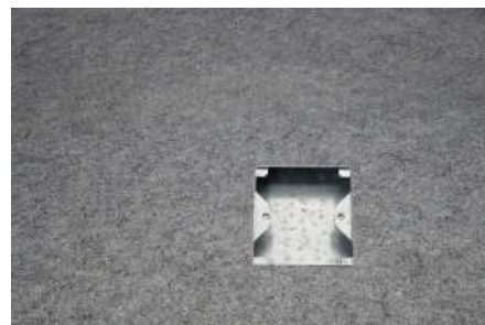
Verschlussplatte entfernt
