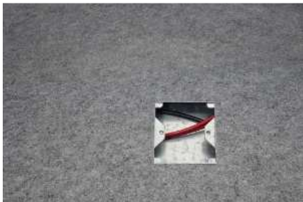
Kabel im den Kabelkanal eingezogen
