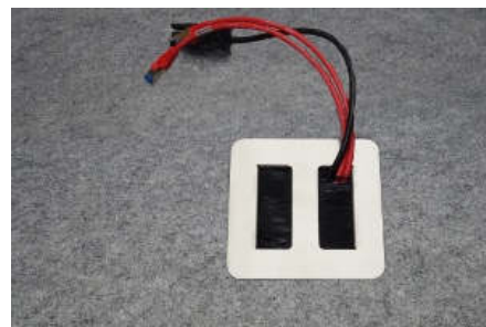
Bodenauslass Montiert
