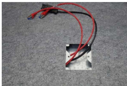
Kabel herausgeführt
