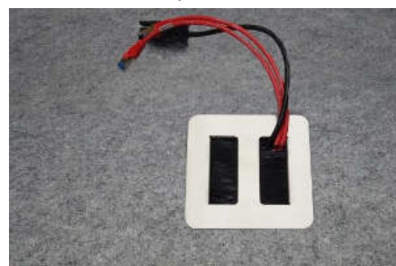
Bodenauslass Montiert
